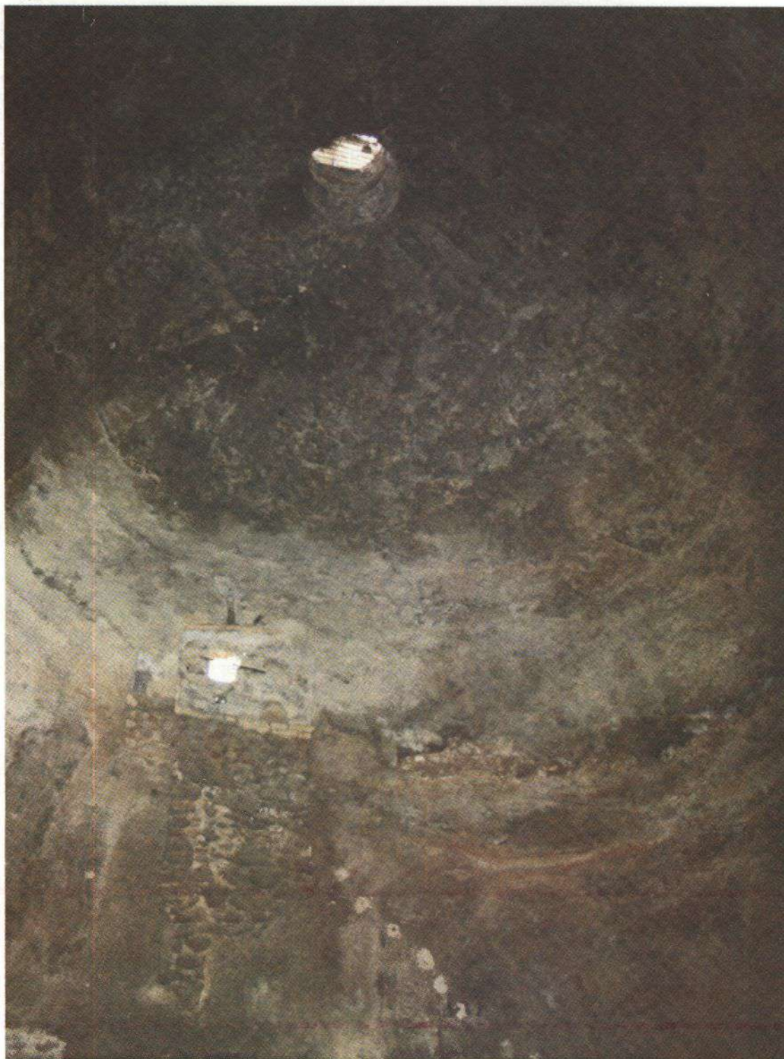
Cava de Cortés. Vista interior de la bóveda, pared sur.
