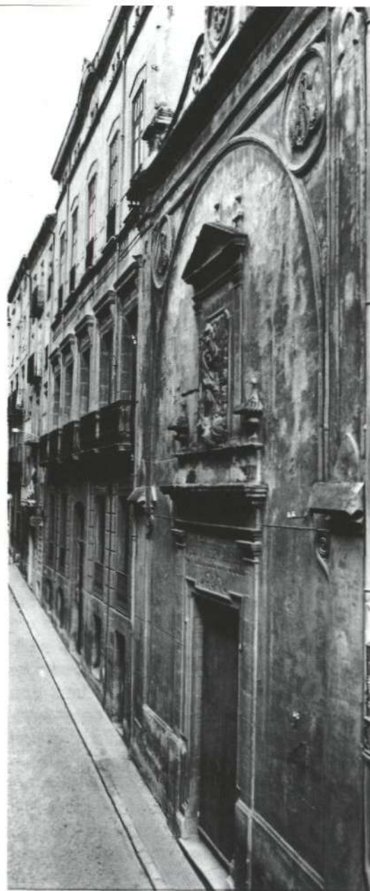
Fachada de la Casa de la Bolla, junto a su capilla de San Miguel.
