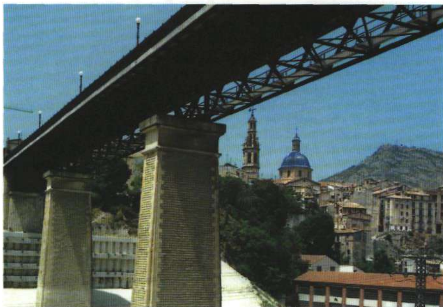
Viaducto de Canalejas.
