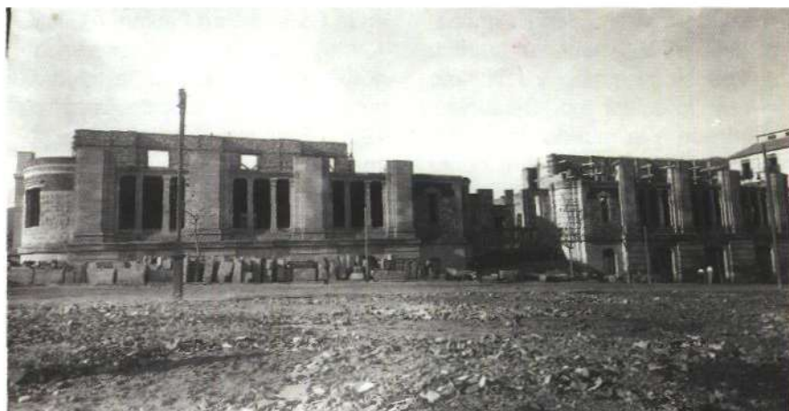
“Construcción del edificio donde se ubica la actual E.P.S. Alcoy”. Los terrenos fueron cedidos por la Real Fábrica de Paños en 1906, al Estado y las obras terminaron en 1936. Foto: Archivo E.P.S.A.
