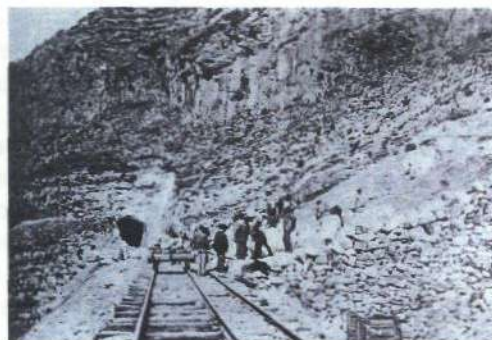
Treballs de construcció al barranc de Bocairent.
