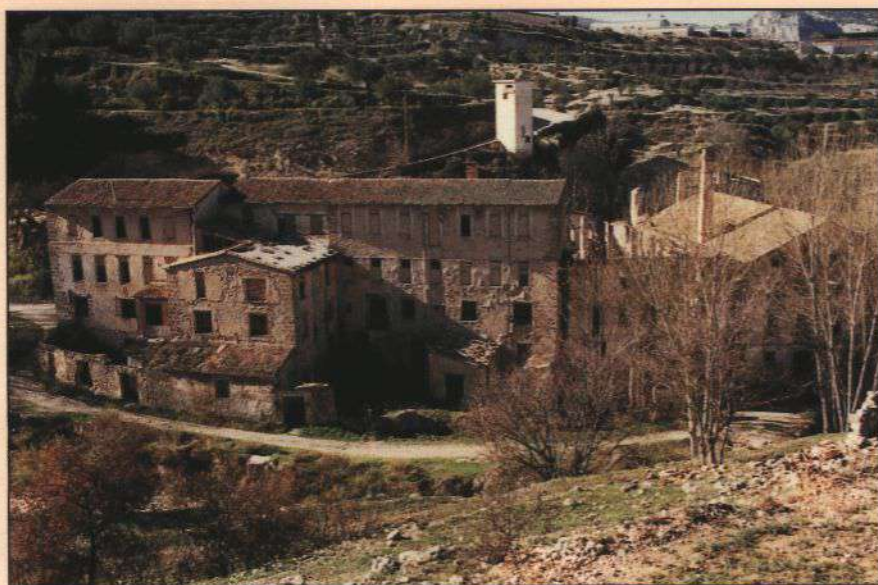
Vista general de tot el conjunt als inicis de la dècada dels noranta, destacant en primer terme la factura de l'edifici del Nou Molí del Ferro, aleshores en bastant bon estat de conservació, i en el que es podia comprovar la tipologia característica d'un molí de paper de procediment manual del segle XVIII.
