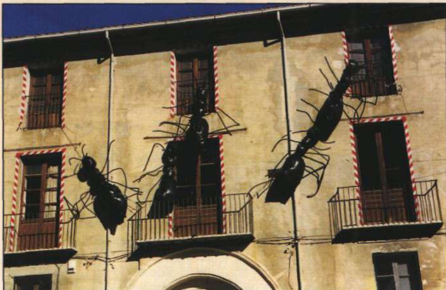
Foto 1: Intervenció-denúncia de l'estat de deteriorament de l'Escola d'Art (1997)
