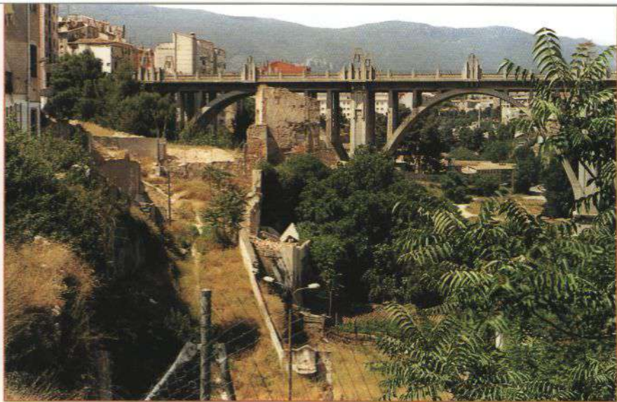
Foto 4: Vista de la Torre Na Valora des de l'emplaçament de la desapareguda Torre de Fraga. La muralla nord devia descendir per on ara va la tàpia fins a la Font de Buidaoli, on probablement se situava el Portal de la Plaça (centre de l'extrem inferior).
