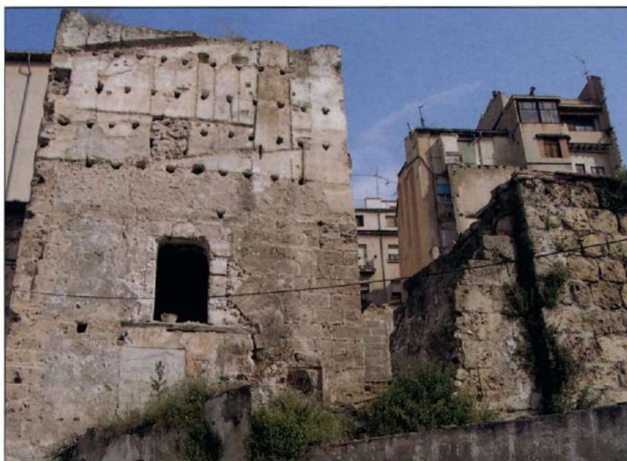
Vista frontal del mur major exterior. Pot advertir-se l'arc "forà" trencat a la part superior per l'obertura d'un forat. Més amunt, a la segona bancada de tapiàl, distingim una de les espitlleres.
