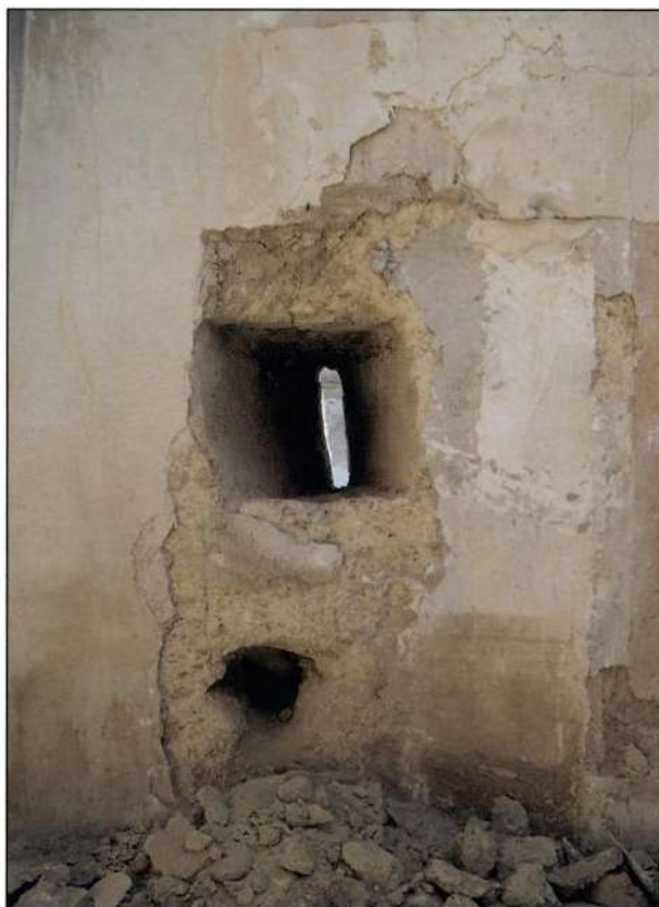
Aspecte d'una de les espitlles del mur oriental, acabada de destapar al pis superior de la torre-portal.
