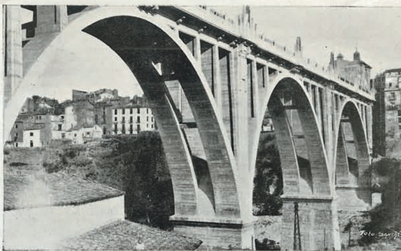
Los ojos del puente y vista parcial de Alcoy
