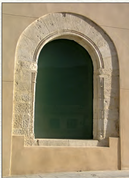
Vista de la porta lateral
