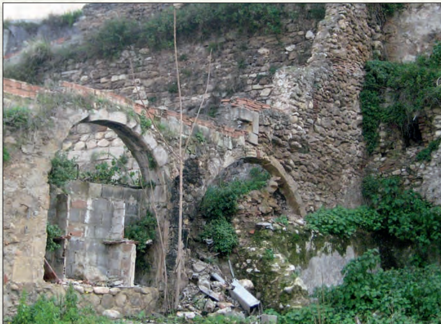
Restes de l'almàssera amb els arcs de mig punt recolzats sobre el mur de la riba.
