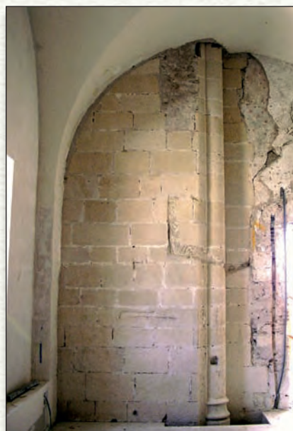
Vista parcial del mur de la testera, amb una columna embotida
