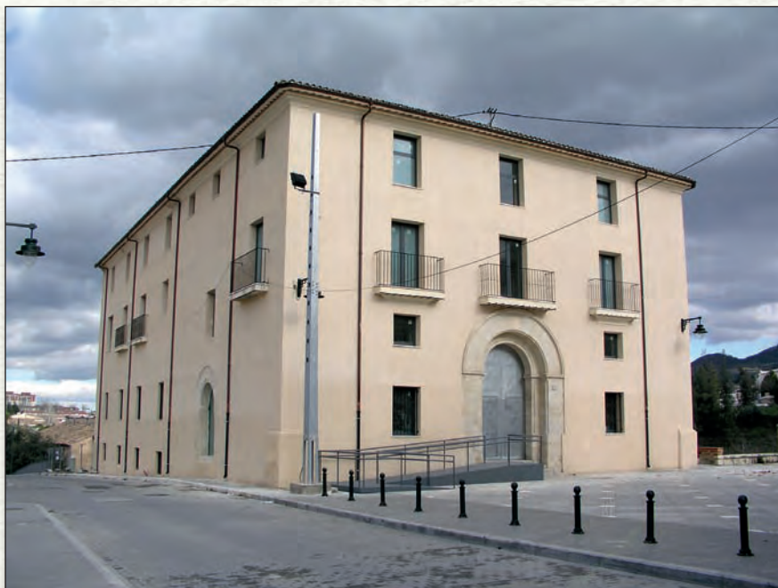
Vista frontal i lateral de l'immoble rehabilitat
