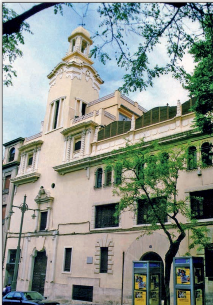
Fachada moderna del Convento del Santo Sepulcro.
