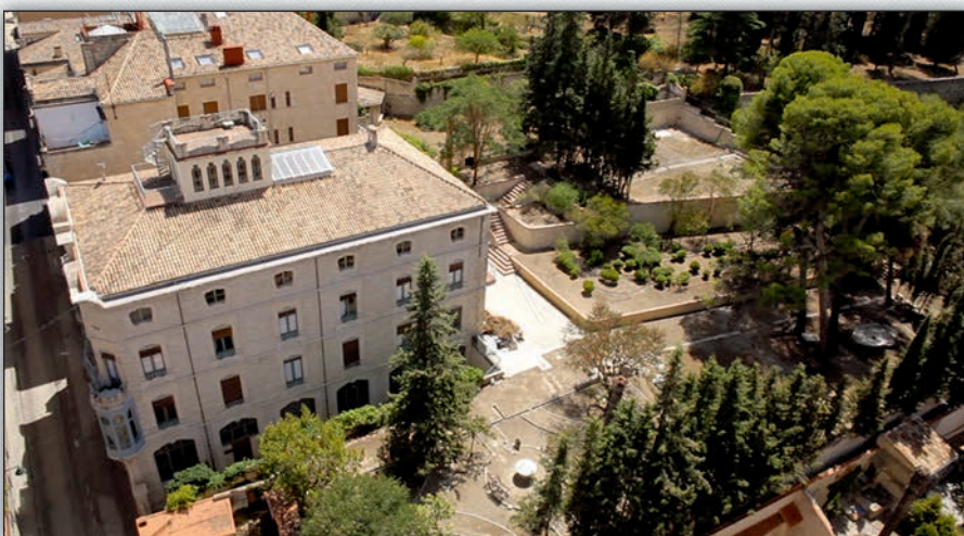
Vista aèria de la Casa Escaló, actual seu del Conservatori.
