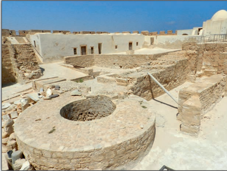
Torre circular de l'angle sud-est del castell de Gerba.
