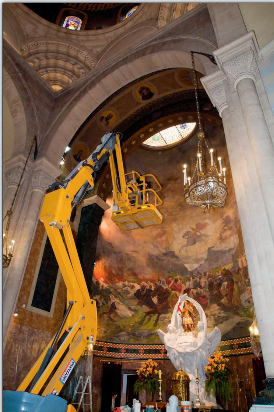
Trabajos de restauración en la Iglesia de San Jorge.
