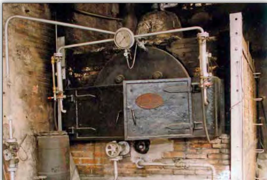
Darrera caldera de vapor instalada en la dècada del 1950.
