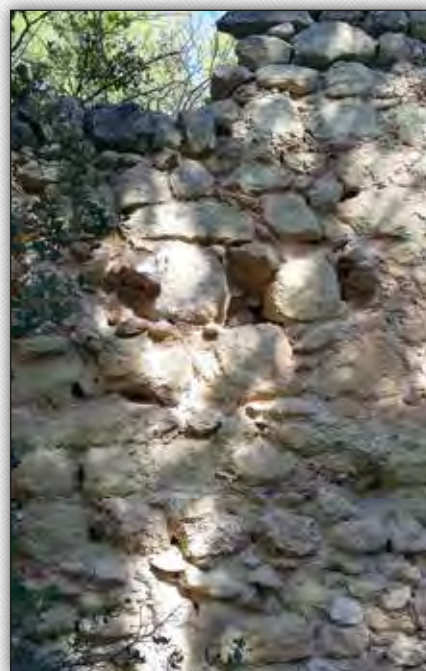
Interior, huecos de alojamientos de vigas.
