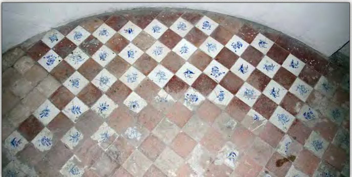
Detall del paviment in situ del cor de la capella de la Mare de Déu dels Desemparats.
