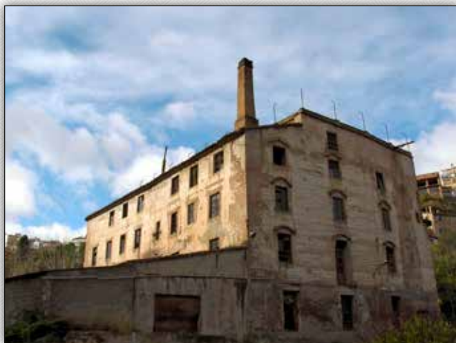
Edifici Maquina Estambreira de la societat “Gosalbez y Perez”, construït al 1825.
