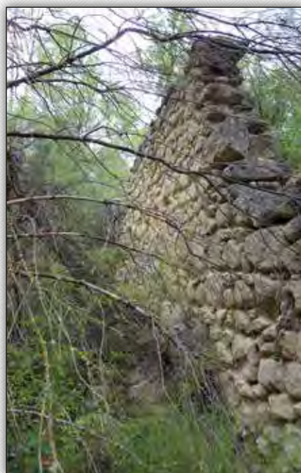
Fachada oeste, exterior.
