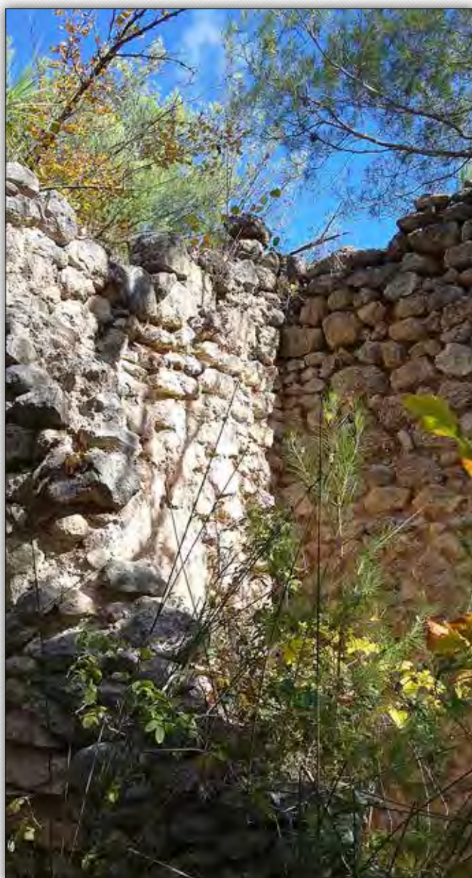
Foso de la rueda hidráulica.
