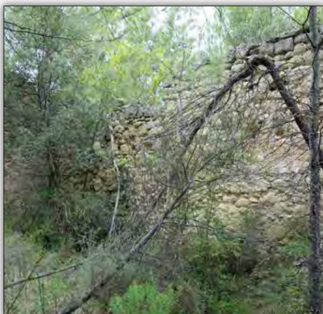
Interior del batán.
