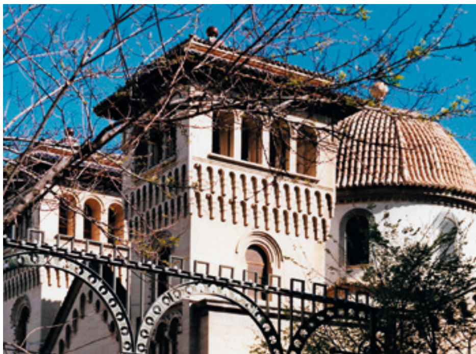
Parte superior del edificio de la iglesia de San Jorge. Al igual que en la fachada, donde pueden observarse las mencionadas reminiscencias del estilo neo-románico. Originalmente las torres laterales que albergan el campanario iban a coronarse con dos pequeñas cúpulas, pero finalmente se remataron con dos cubiertas piramidales.
